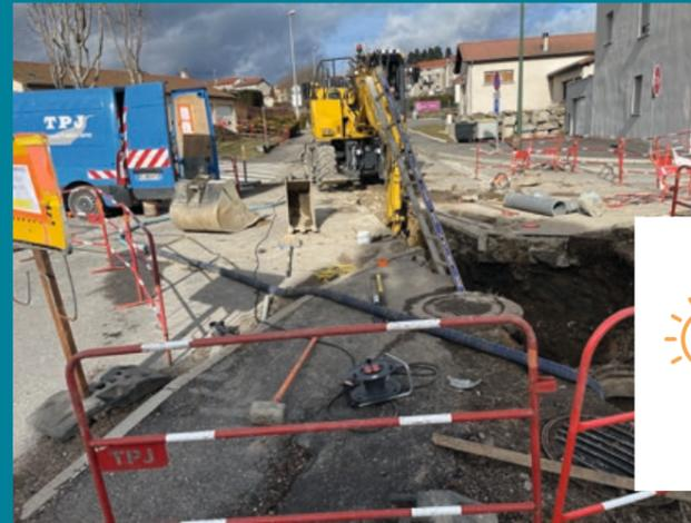
Après avoir constaté des infiltrations d'eaux pluviales sur le réseau rue de l'Étang, des travaux de séparation d'eaux pluviales et d'eaux usées sur les canalisations d'assainissement ont été nécessaires. Ces travaux ont été repoussés en février afin de ne pas pénaliser les commerces en période de fêtes.
