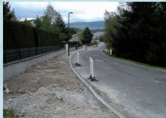
Rue Marcellin Champagnat - En travaux
