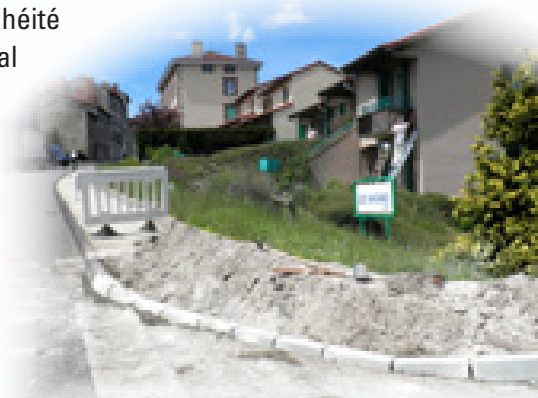
Abaissement du trottoir rue de la Sémène
