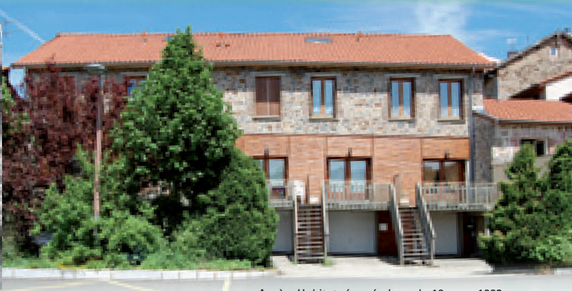
Après. Habitat rénové place du 19 mars 1962
