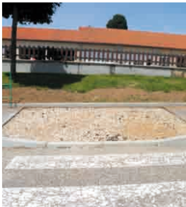
Abaissement d'un trottoir devant l'école de l'Étang
