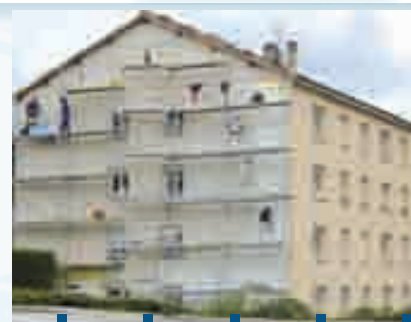
Réhabilitation de l'immeuble "Le Bergazzy"
