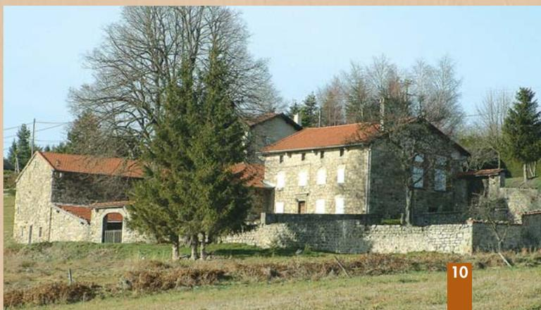
La disposition en équerre est souvent adoptée pour protéger la cour des vents dominants : Nord et Ouest. En général, la façade principale est orientée au sud, à l'est ou au sud-est. Il y a peu ou pas d'ouvertures sur le mur situé au Nord.
