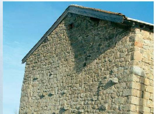
Les murs comportent deux parements de pierre, avec, entre les deux, un remplissage de terre battue pour l'isolation. Afin d'augmenter la solidité de l'ensemble, des pierres nommées liens ou boutisses traversent le mur de part en part. Sur certains murs elles dépassent à l'extérieur. A noter qu'il n'y a aucune ouverture sur le pignon.
