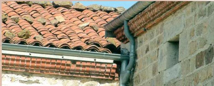
Dans une ancienne ferme du bourg, on trouve ce curieux entablement fait de briques. On remarque, sur les tuiles creuses, des pierres destinées à les maintenir par temps de vent.
