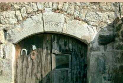
Pour résister au poids des murs, les linteaux des ouvertures - en particulier les porches de grange ou d'écurie - étaient taillés en arc. Ici un arc à 3 "claveaux". Ils peuvent comporter la date de construction ainsi que les initiales du propriétaire qui l'a fait édifier.
