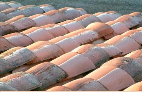
Si au nord du département de la Loire, dominaient des toits à forte pente, couverts de petites tuiles plates, dans le sud et notamment dans le Pilat, on trouvait le toit provençal, à faible pente - environ 25° - couvert de tuiles "canal" ou tuiles creuses.
