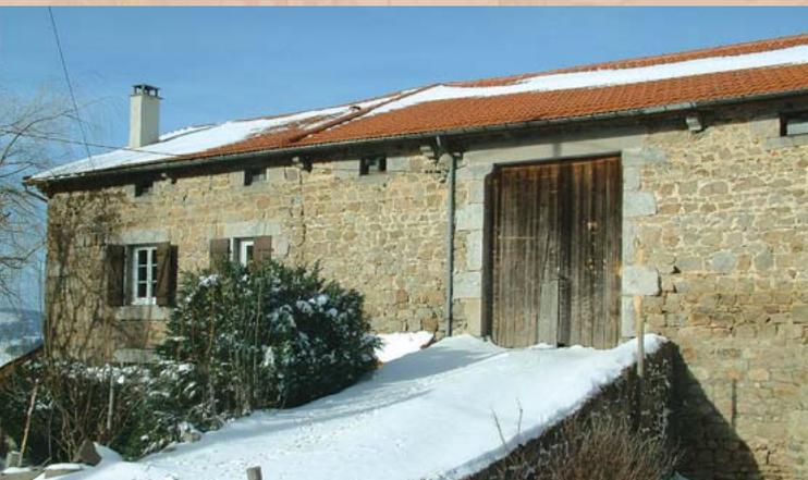
On observe deux volumes adjacents : l'habitation et le bâtiment agricole. Ce dernier comporte l'étable en général basse sous plafond avec, au-dessus, la grange à laquelle on accède par une rampe - ou montoir - souvent située du côté Nord ou bien du côté où la pente le permet.
