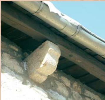
Usage propre au canton de Saint-Genest Malifaux : la "sablère" (poutre de bois) soutenue par des "corbeaux" en granite supporte les extrémités du toit.
